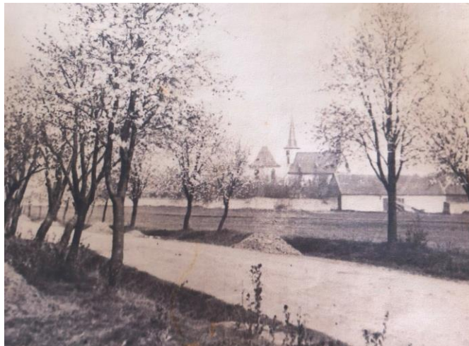
Původní kvetoucí alej na příjezdu do obce
